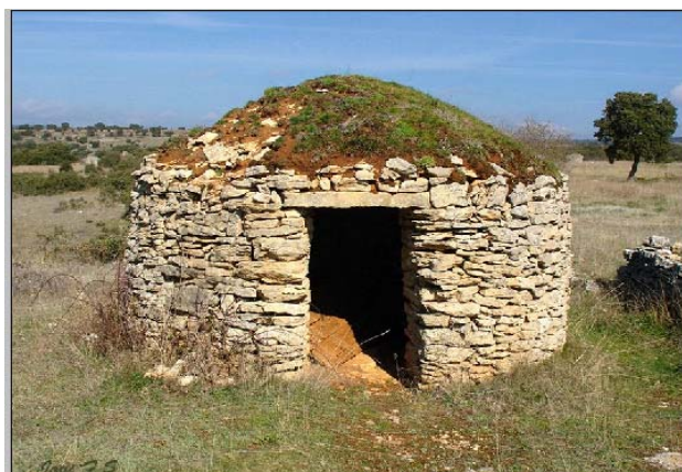
Figura 62. Antiguo caseto o “chozo” de campo
