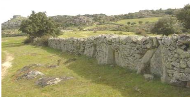
Figura 61. Pared de campo con piedra menuda e” hincones”
