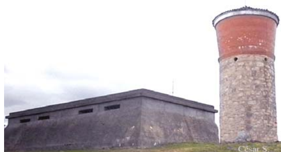
Figura 102. Los nuevos depósitos de agua
